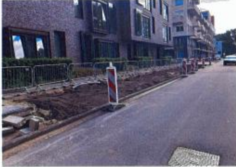
Gedeelte dat nog dicht gestraat wordt,
