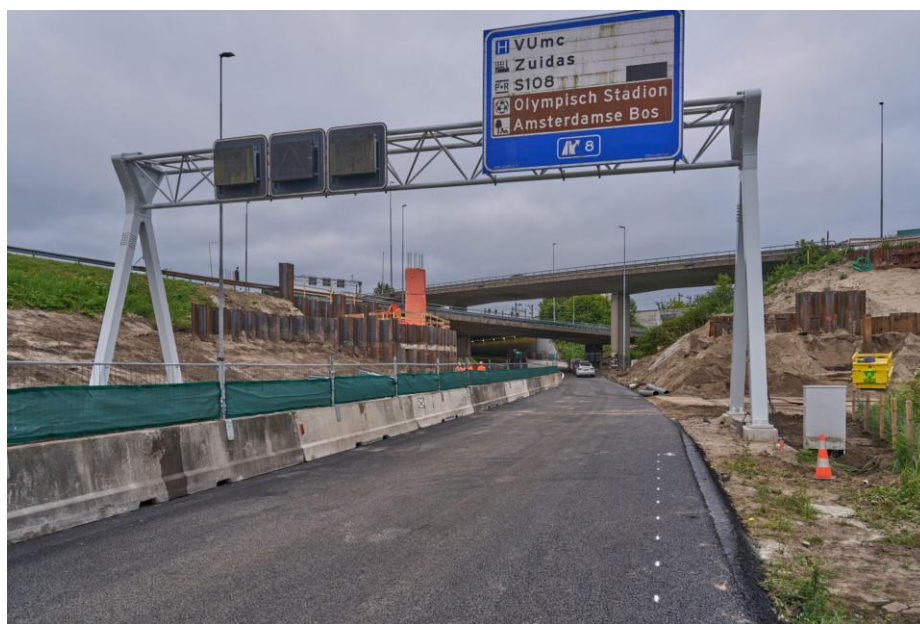
Bouwen aan steunpunten nieuwe fly-over bij knooppunt De Nieuwe Meer
