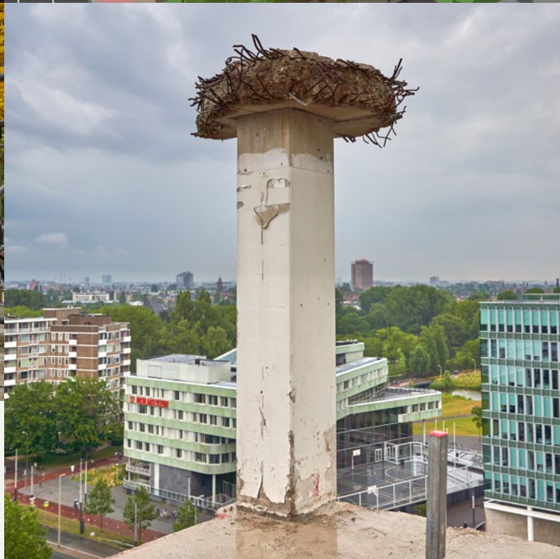
Sloopwerkzaamheden in het WTC ten behoeve van Tower Ten Foto: Marcel Steinbach
