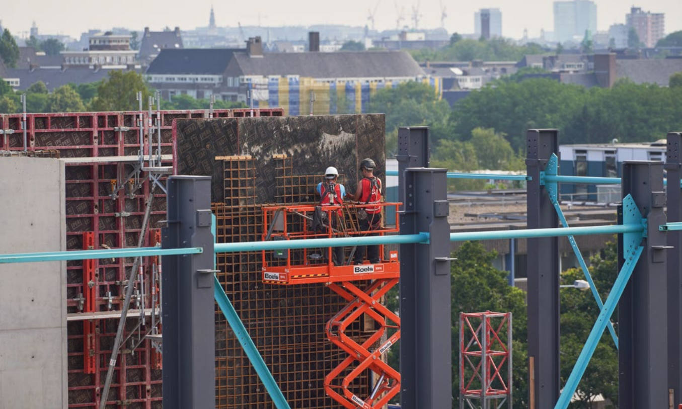
Nieuwe rechtbank in aanbouw in Parnas Foto: Marcel Steinbach
