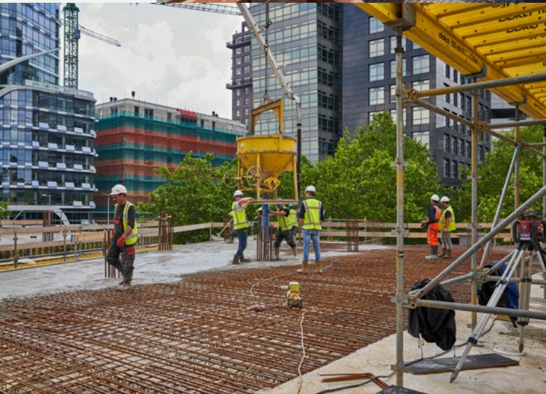
Bouwen aan Valley Foto: Marcel Steinbach
