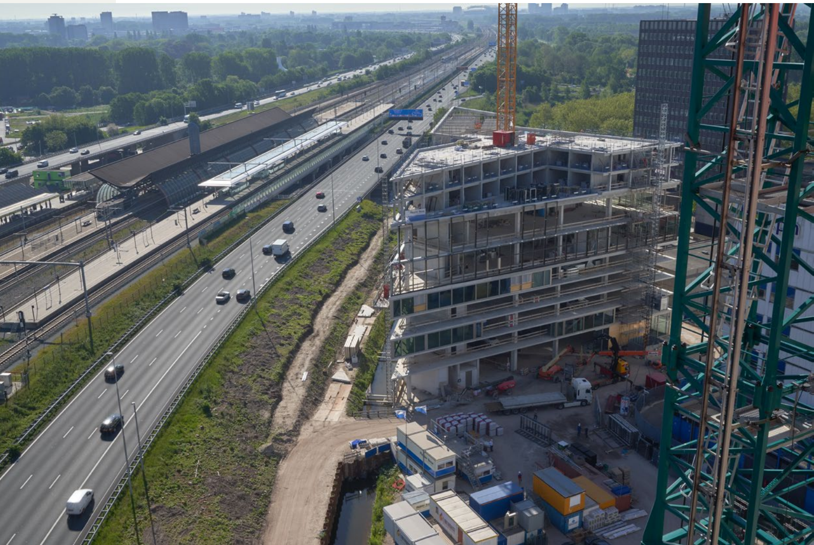
Het Van der Valk hotel in aanbouw Foto: Marcel Steinbach
