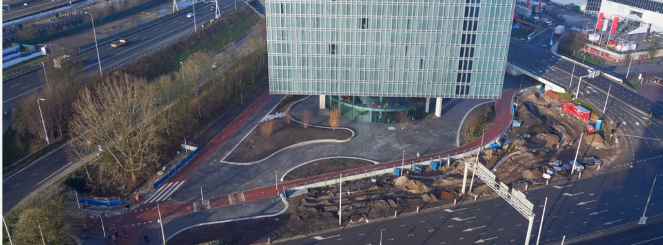
Inrichting van de openbare ruimte bij nhow Amsterdam RAI hotel Foto: Marcel Steinbach
