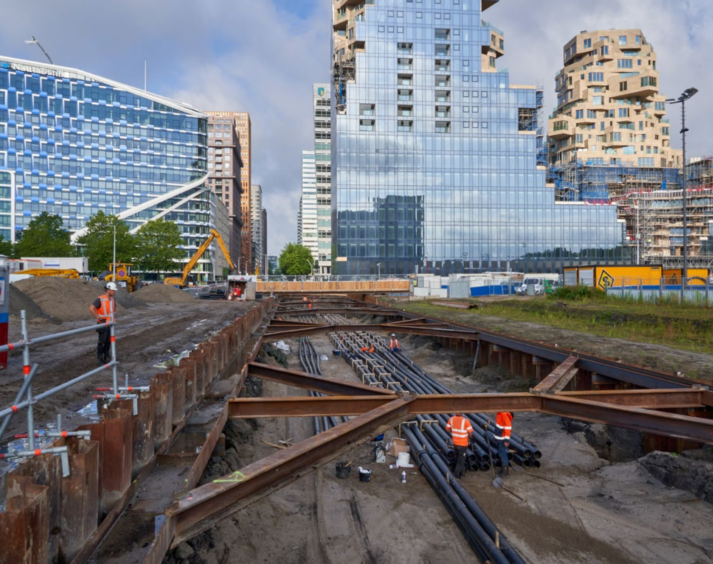
Kabels en leidingen onder de toekomstige Maurice Ravellaan Foto: Marcel Steinbach
