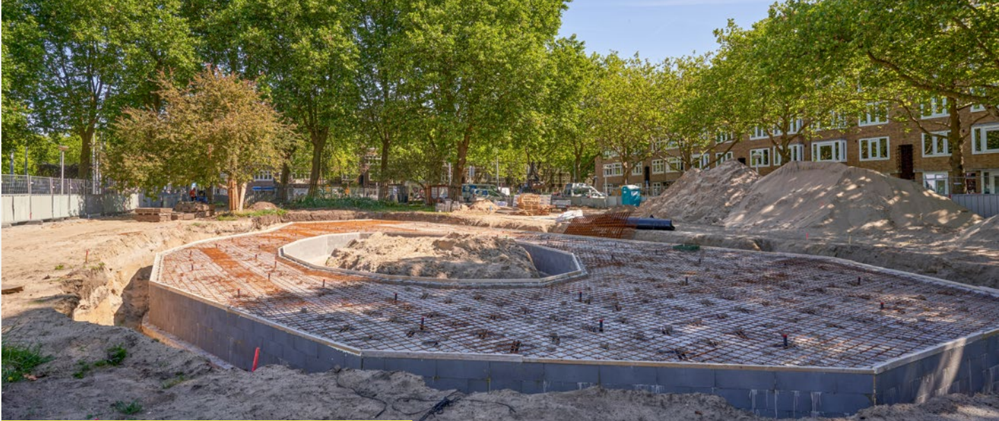
▶ Aanleg van een waterbergings-systeem onder het Europaplein Oost Foto: Marcel Steinbach
