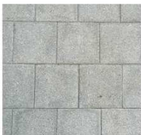
Betontegels Breccia 30x30cm op voetpaden
