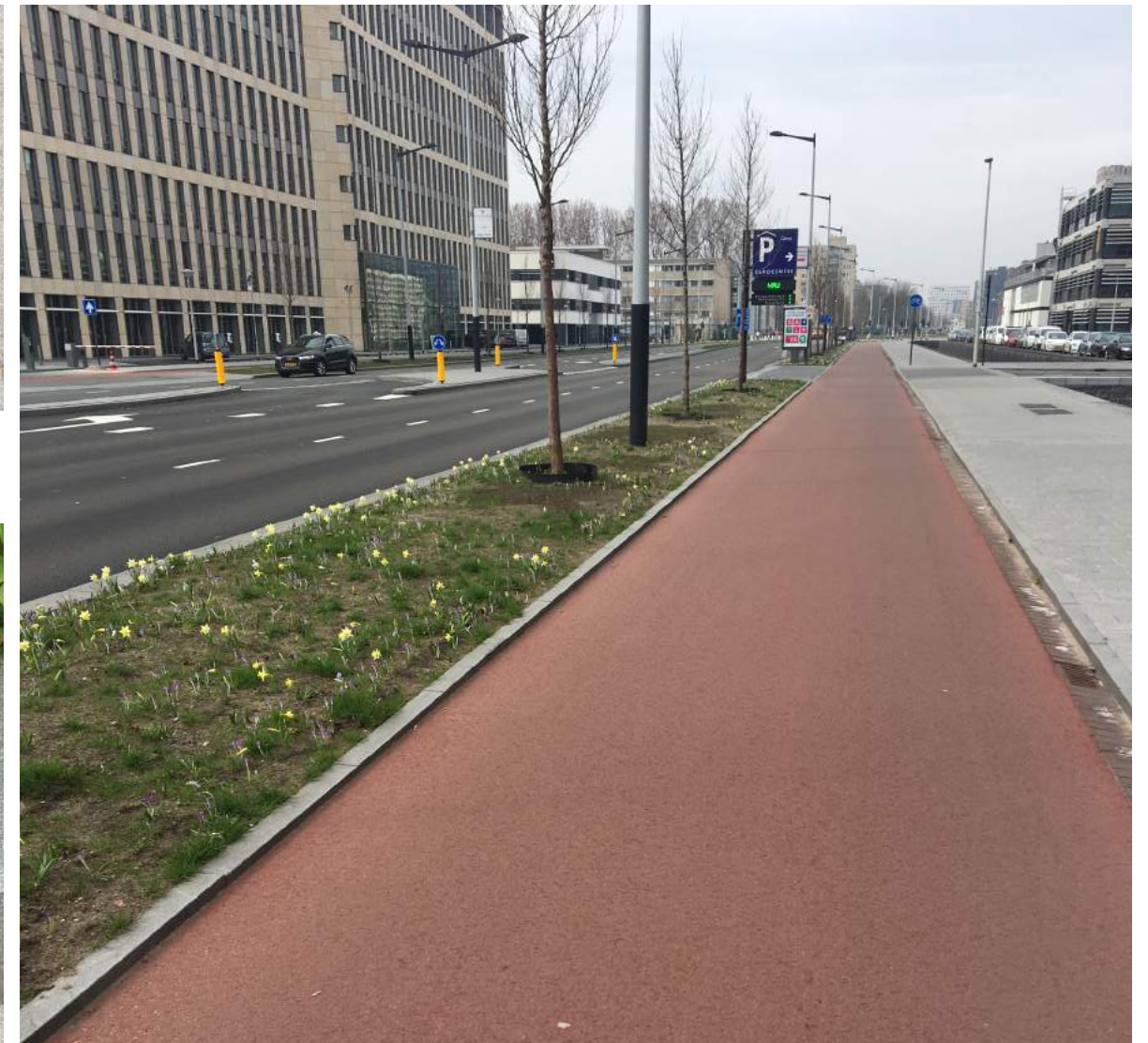
Gebruik rood en zwart asfalt Boelelaan oost in combinatie met natuursteen banden (Oriënt Blue)
