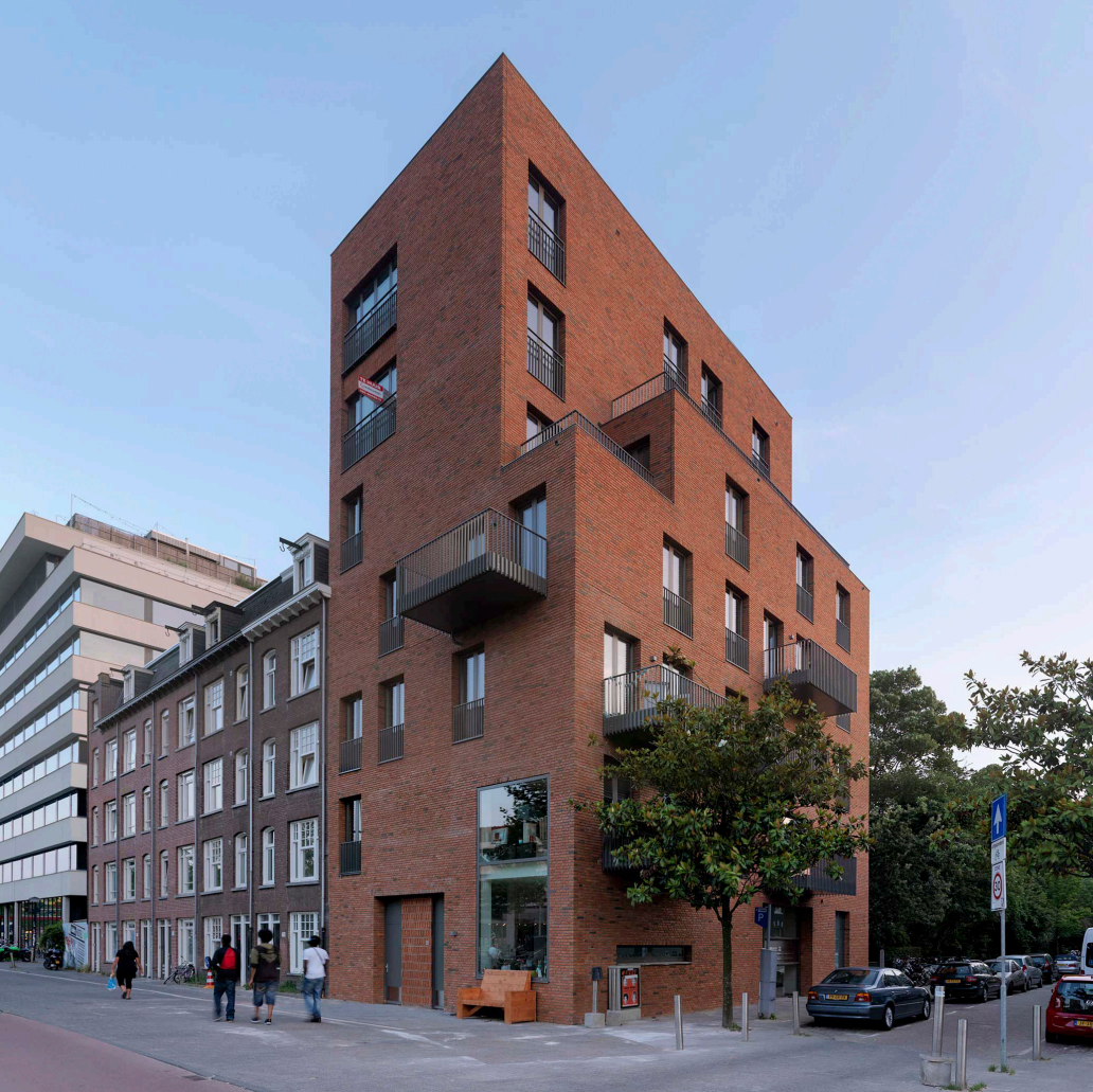
Woongebouw aan de Wibautstraat 120 (Amsterdam). Ontwerp: Bedaux de Brouwer. Foto: Michel Kievits.
