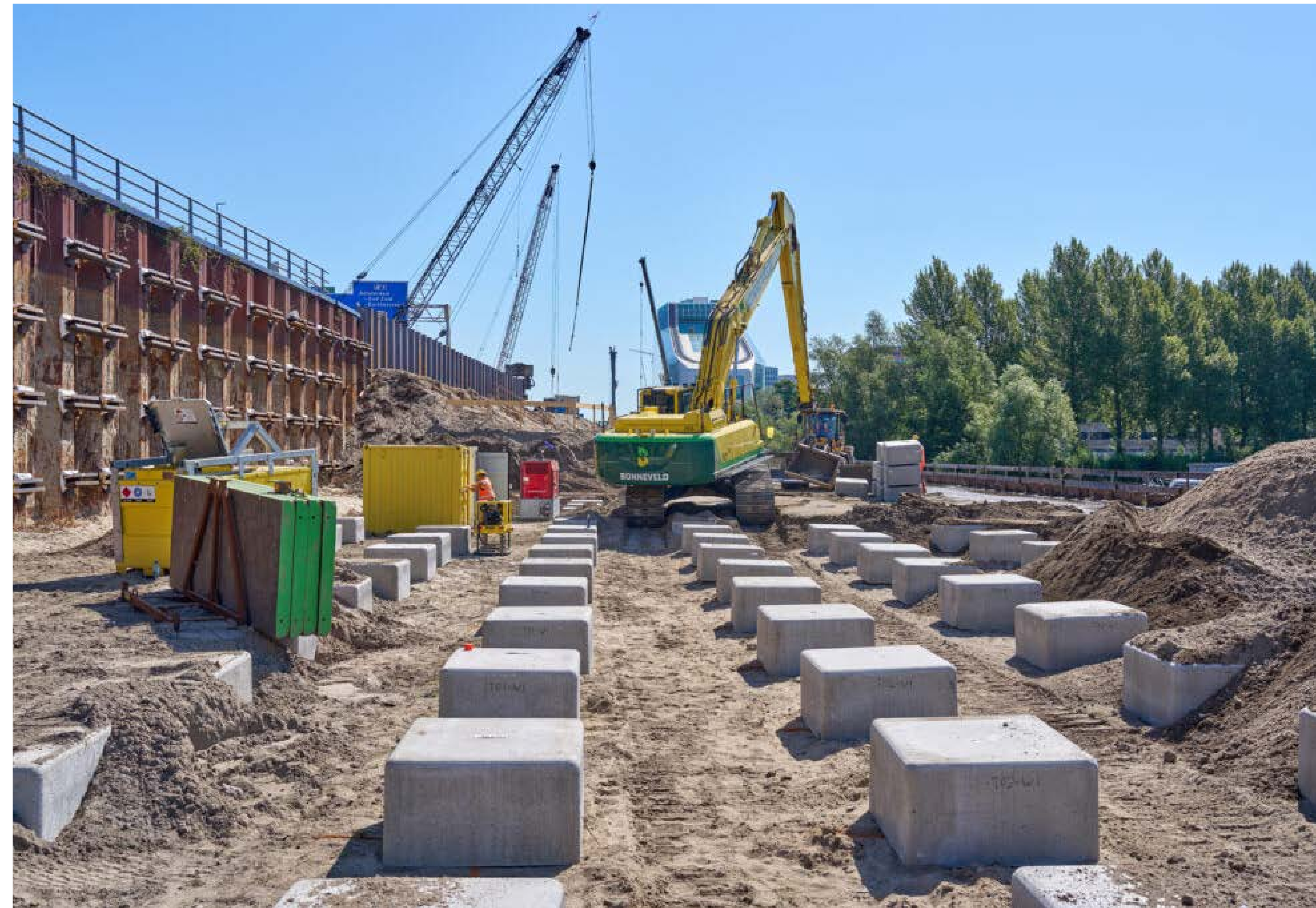
Aanbrengen paaldeksels
