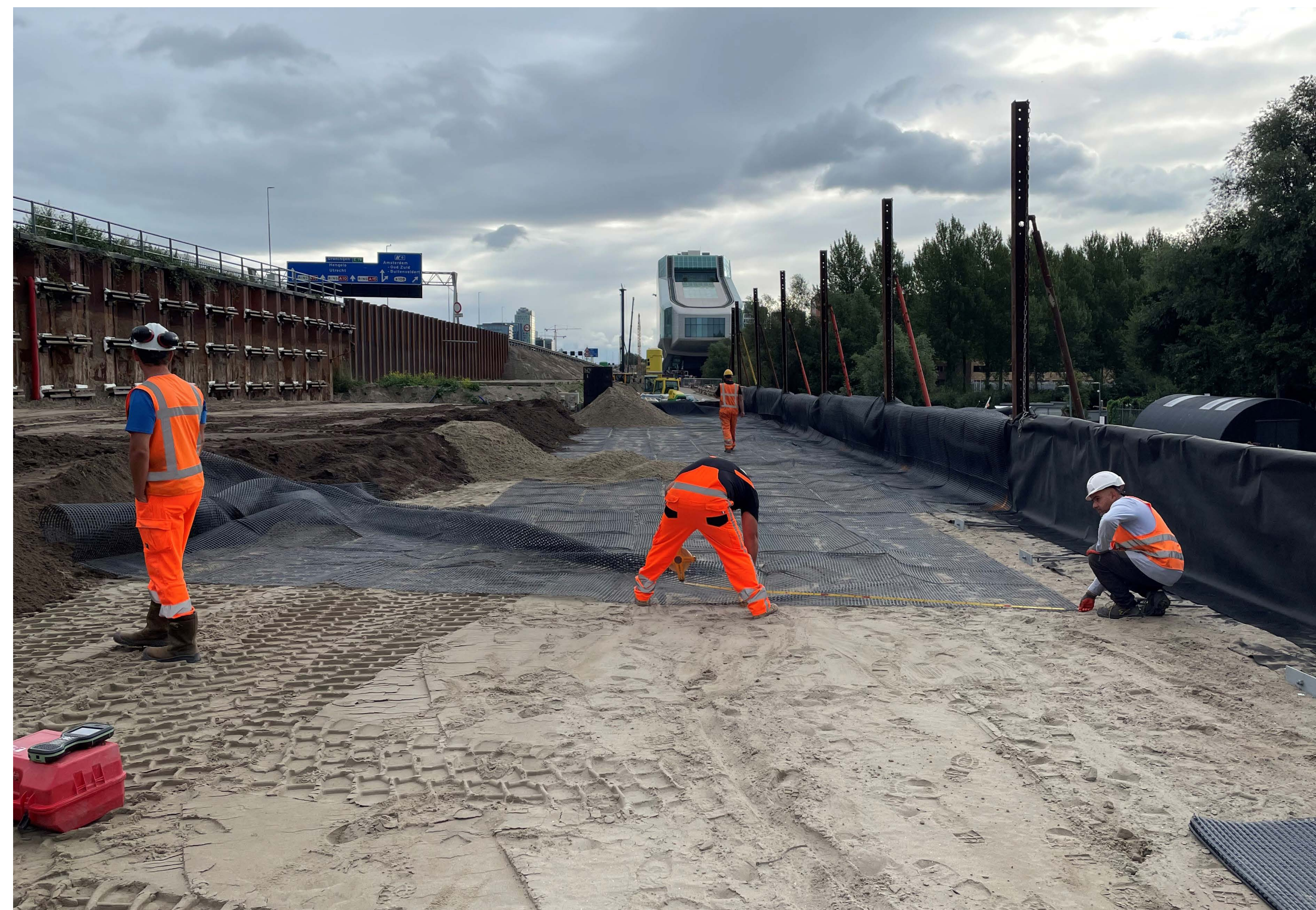
Opbouw matras: geotextiel en zand
