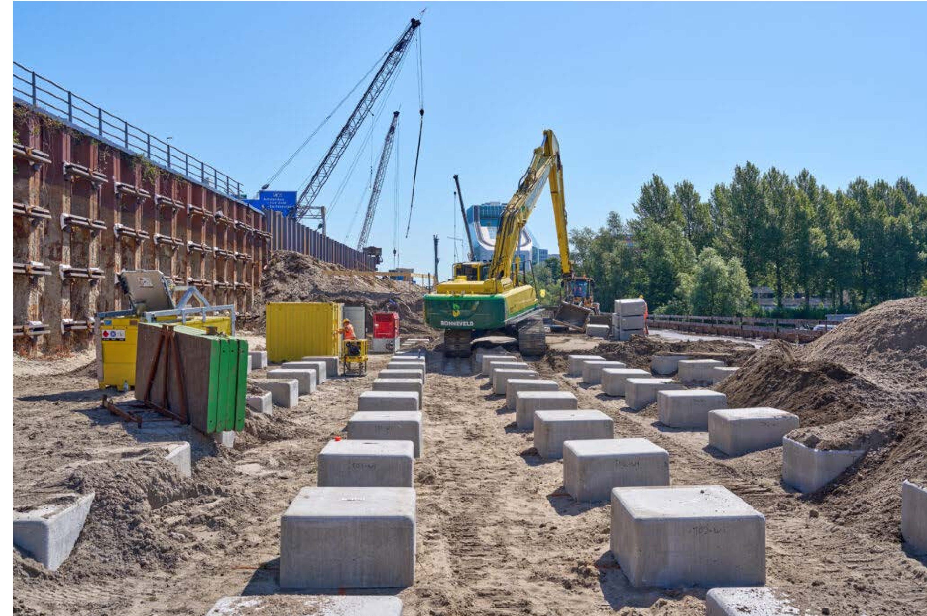
Aanbrengen paaldeksels
