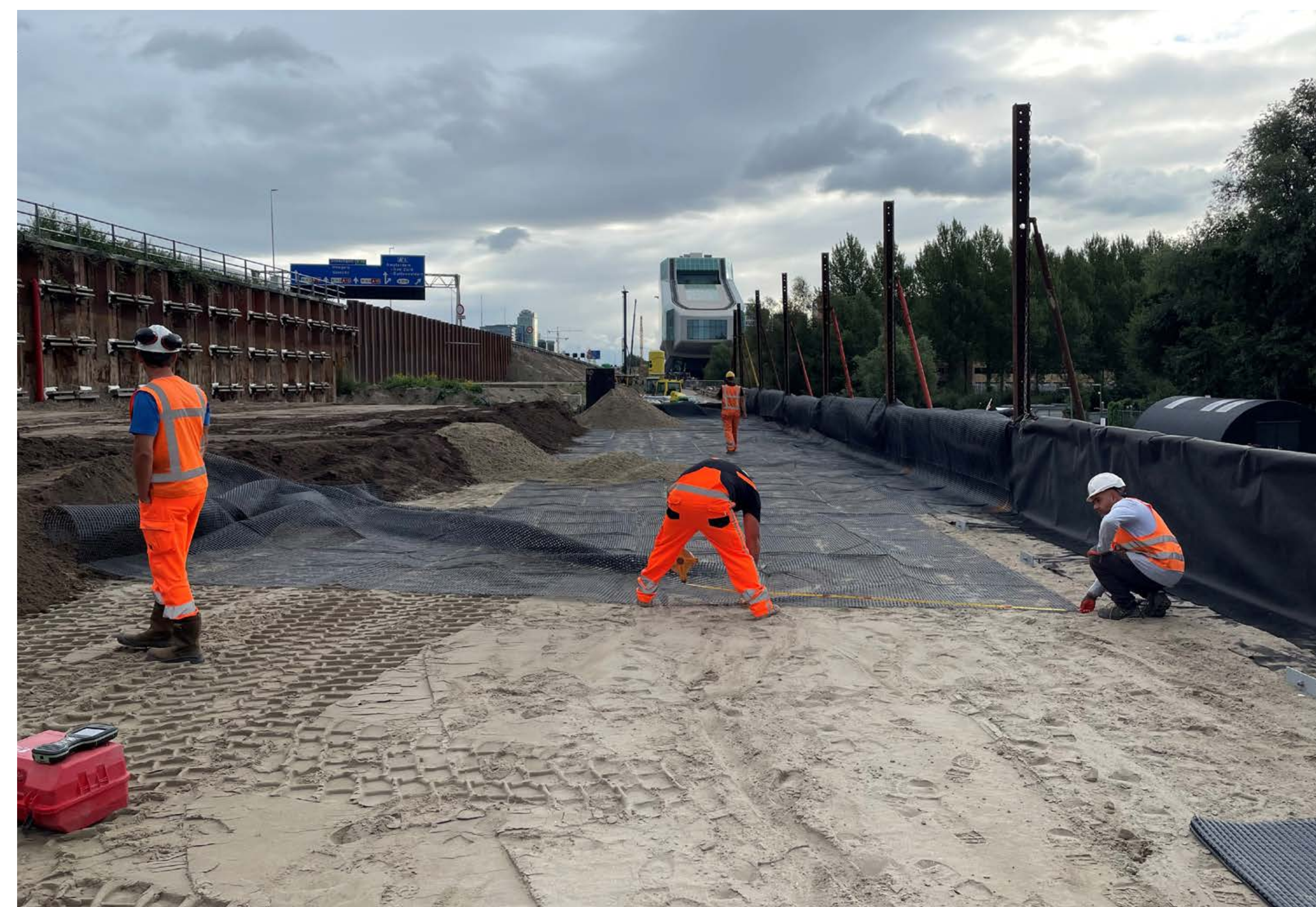
Opbouw matras: geotextiel en zand
