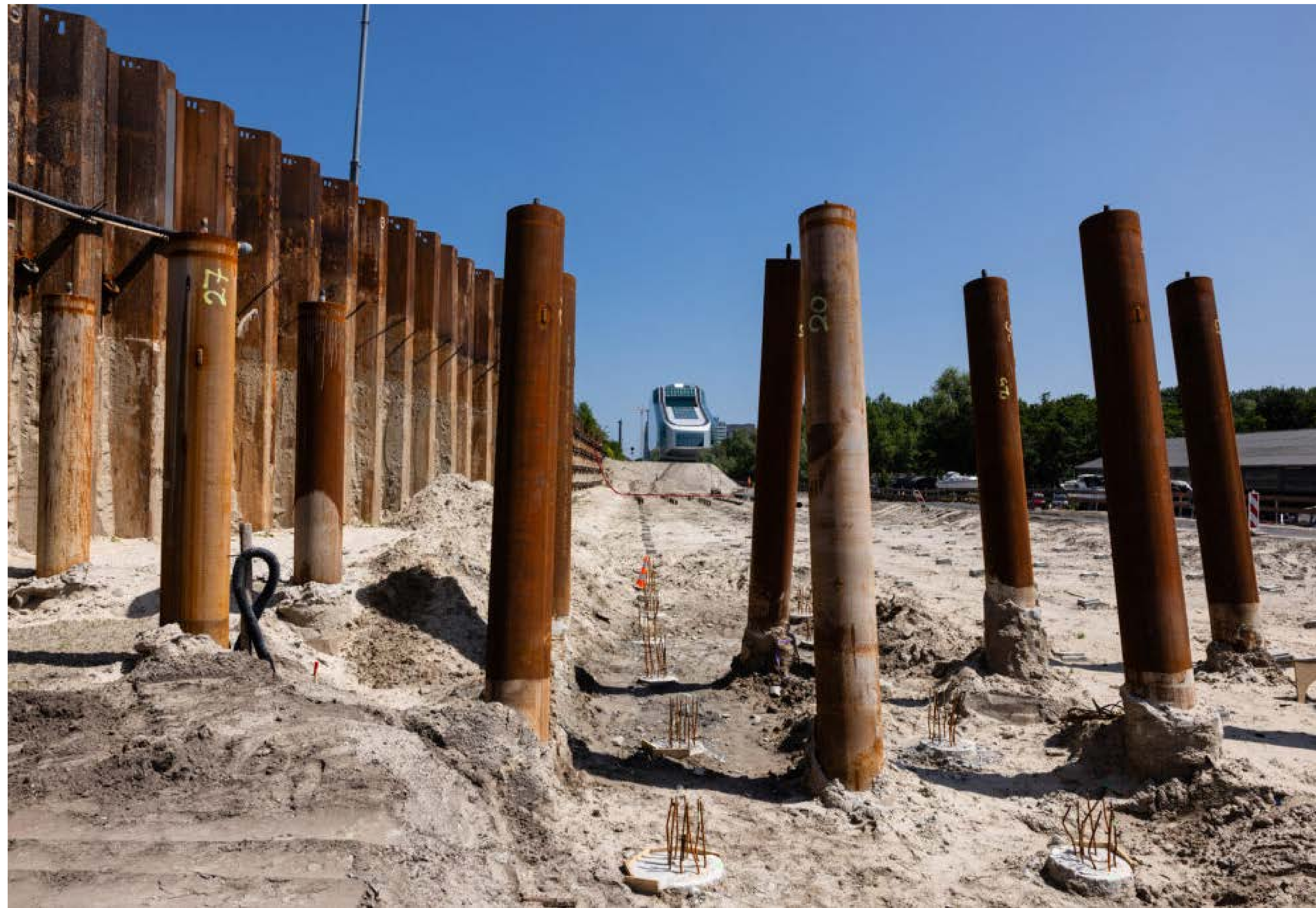
Aanbrengen van 3500 palen
