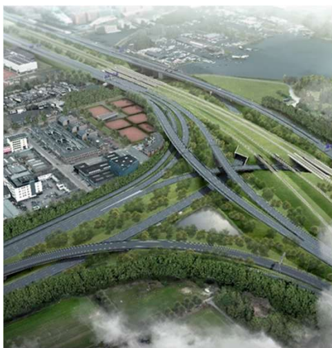
Reconstructie Knooppunten De Nieuwe Meer: sinds 2024 in uitvoering Amstel: eind 2025 gegund aan Amstel Verbindt
