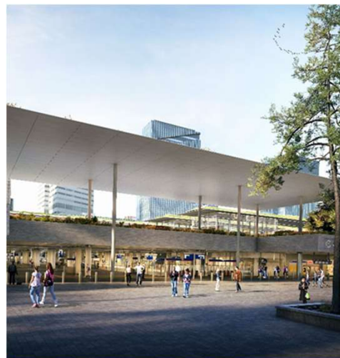
OV Terminal In uitvoering
