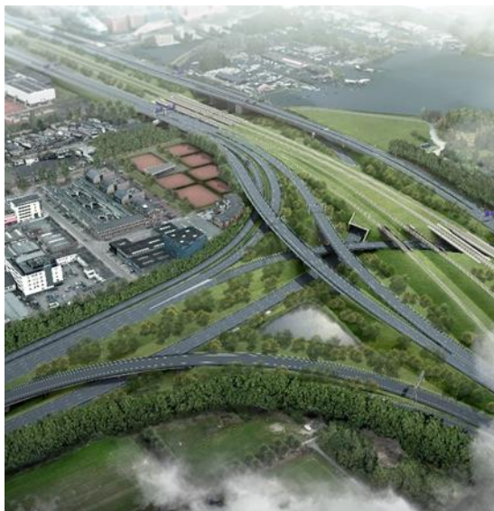
Reconstructie Knooppunten De Nieuwe Meer: sinds 2024 in uitvoering Amstel: sinds februari 2025 in aanbesteding
