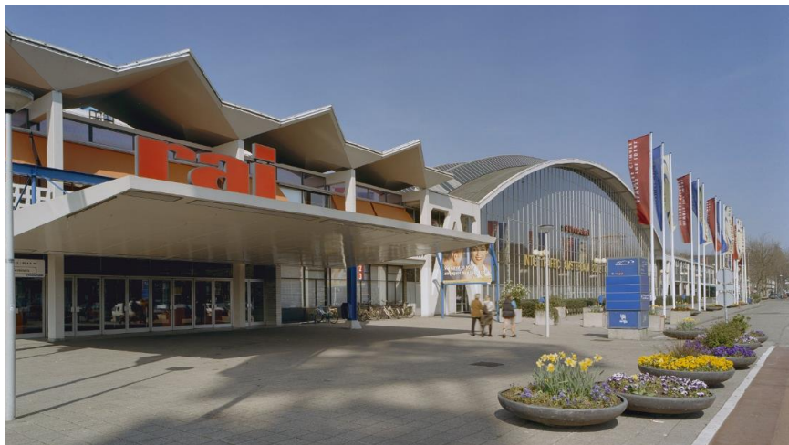
Hoofdentree RAI in 2002 met de oude inrichting. Beeldbank RCE: A.J. van der Wal, 350.424, 2002.
