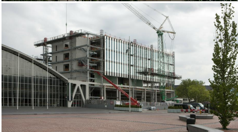
Boven: foto van de twee schroeven van het parkeergebouw. M&A, 14 september 2023. Onder: het Amtrium in aanbouw. SAA: Eric Dix, D1047900041, 2014.
