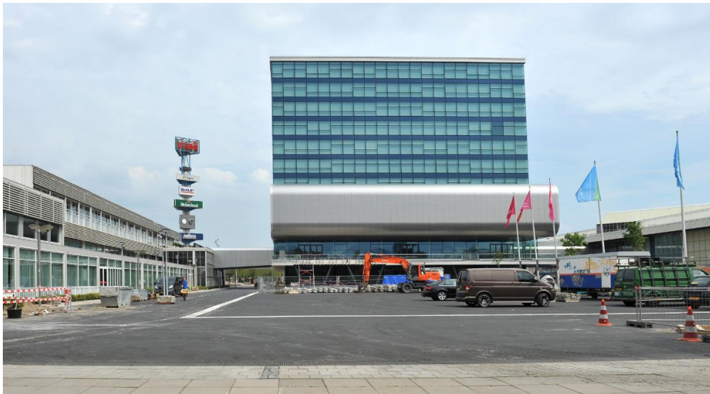
Achterzijde van het Elysium, gezien vanaf het plein voor het Congressentrum. Links de zuidgevel van het Europacomplex, waarvan de in de jaren '90 geplaatste droogloop weer is verwijderd. SAA: Doriann Kransberg, D10134004195, 2011.
