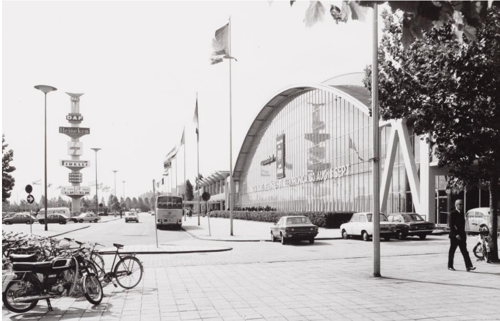
Pleininrichting voor het Europacomplex, gezien in zuidelijke richting. SAA: Arsath Ro'is, 010122003012, 1974.
