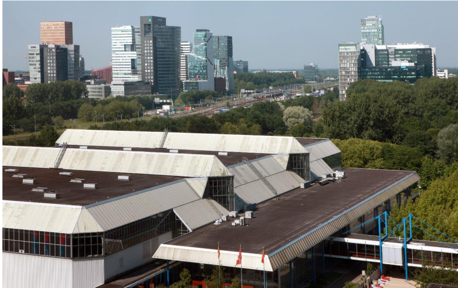
De Parkhal met entree en luchtbrug en op de achtergrond het Beatrixpark en de hoogbouw van de Zuidas, gezien in zuidwestelijke richting. SAA: Doriann Kransberg, D10134003280, 2004.
