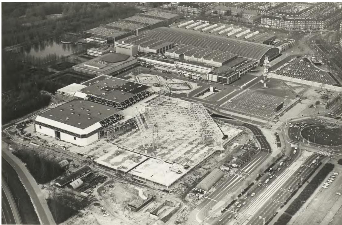
Uitsnede van een luchtfoto, gezien in noordwestelijke richting. Op de voorgrond de bouw van het Hollandcomplex met parkeergarage. De ondergrondse parkeergarage is op dat moment al gereed. SAA: Capital Press & Photo Productions BV, AANAo873600001, 1980.
