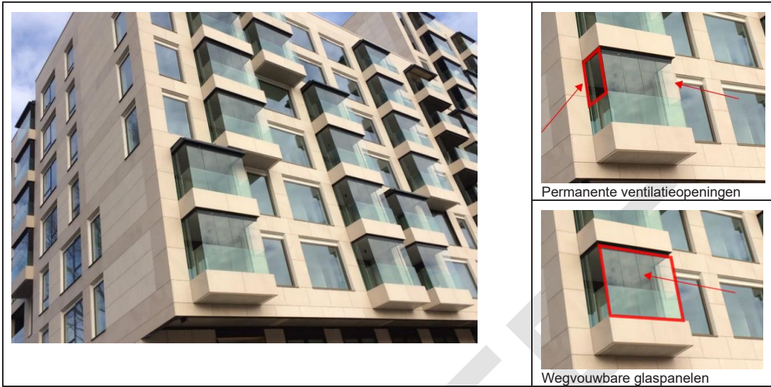
Figuur 2.1: Verdiepingshoog verglaasde balkons in project DeFred020 in Amsterdam
