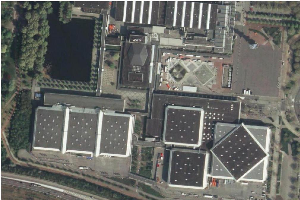
Luchtfoto van de RAI uit 2003, na realisatie Parkhal. Goed zichtbaar zijn de nieuwe luchtbruggen en nieuwe / verplaatste drooglopen, en de achterkantsituatie die is ontstaan aan de zuidzijde. Bron: data.amsterdam.nl
