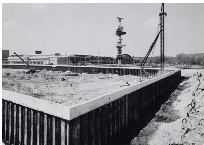
Figuur 9: Aanleg parkeergarage RAI [Stadsarchief Amsterdam]
