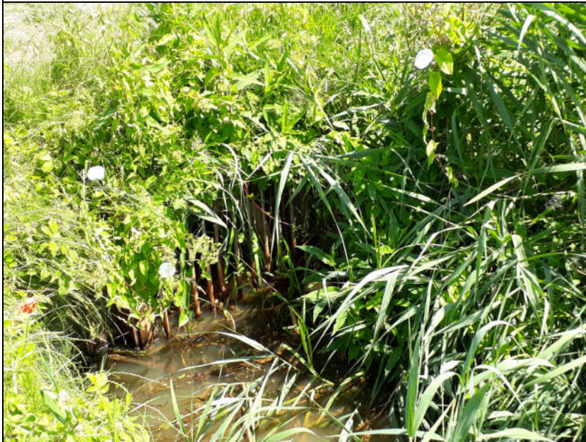
10 Roosterhek en toegang tot duiker die in noordelijke richting langs voetbalclub Arsenal loopt.
