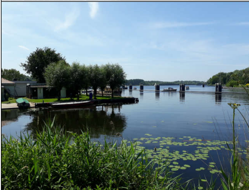
18 Uitzicht op wacht/aanmeer plaatsen voor de sluis en De Nieuwe Meer, genomen van onder de A10 in zuidelijke richting.
