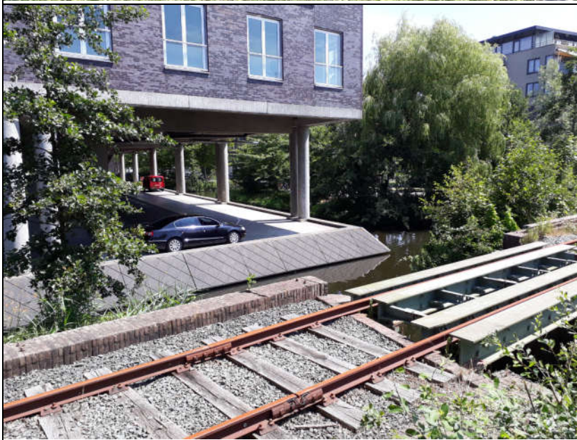
36 Deel van het watersysteem tussen het Gaffelaarspad en het Pramenpad, verbonden met De Nieuwe Meer door een open verbinding en (spoor)brug.
